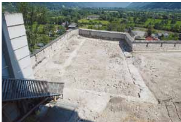
Blick auf die Mauerreste der Nordostbastion, Sektor 3. – Aufnahme A. Steinegger.
